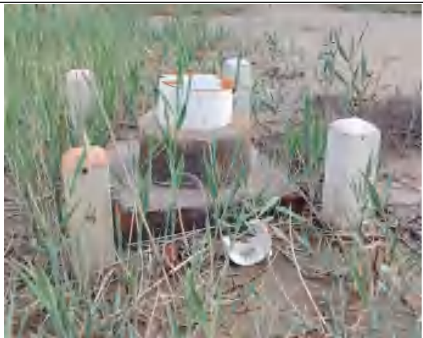
地下水监测井 2
