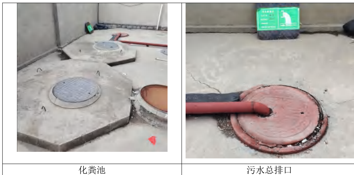
图 4.1-1 化粪池及污水排放口
