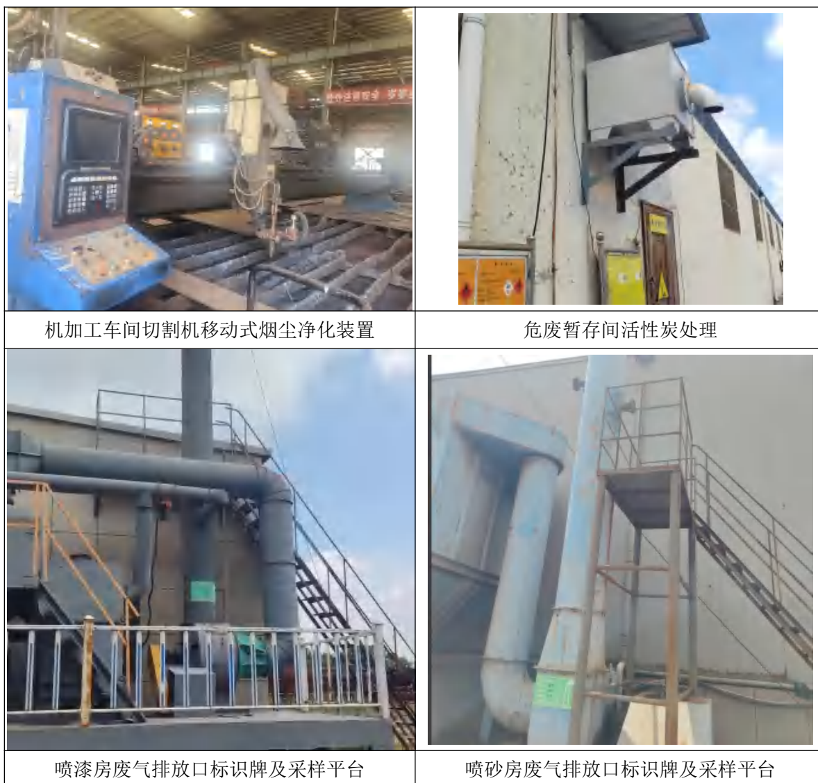
图 4.1-3 废气处理设施及监测点设置情况
