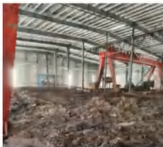
油泥砂贮存间内部油泥砂池
