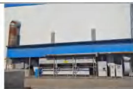
油泥砂贮存间南侧
