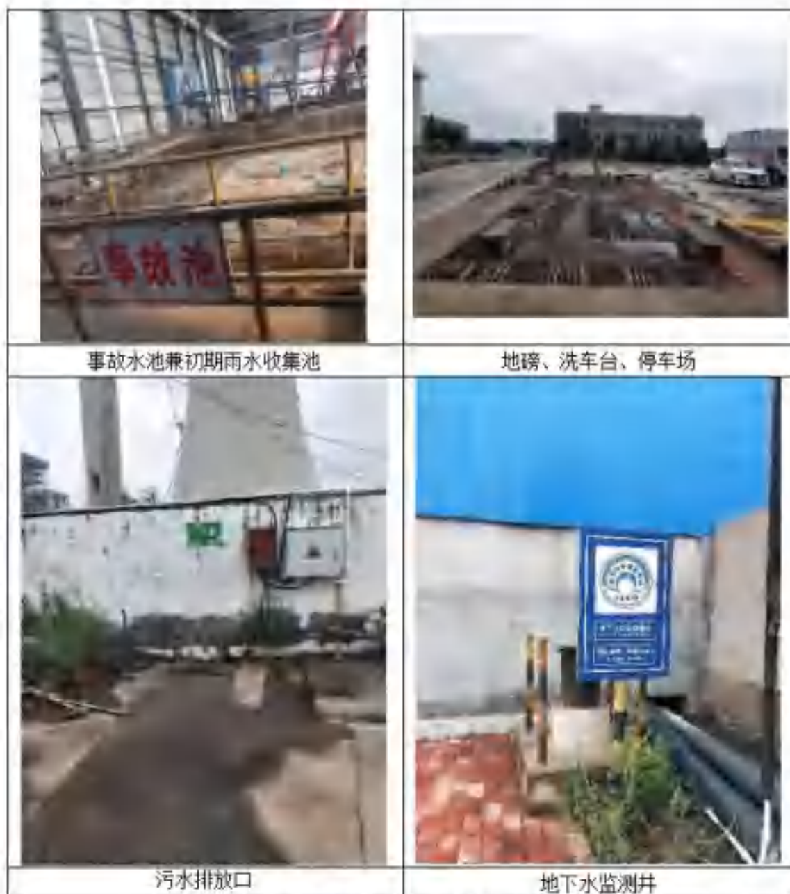
图 3.3-1 现有工程现场照片
