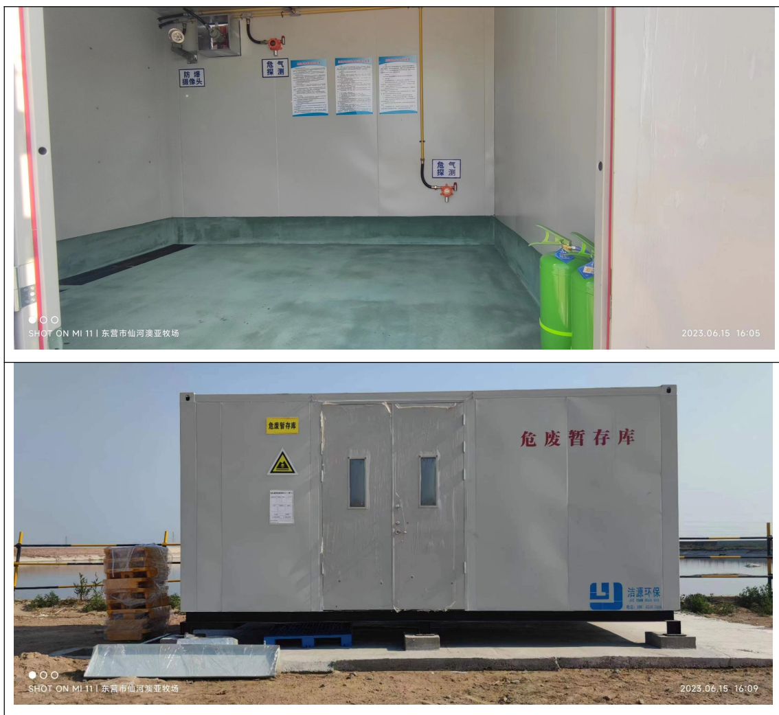
图 4-5 危废暂存间现场照片
