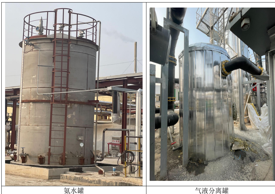
图 3-9 项目现场建设现状情况图
