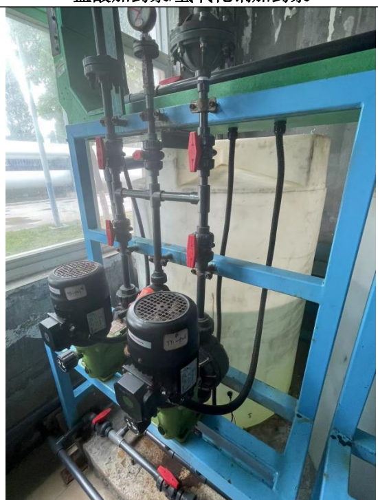
超滤反洗加酸装置
