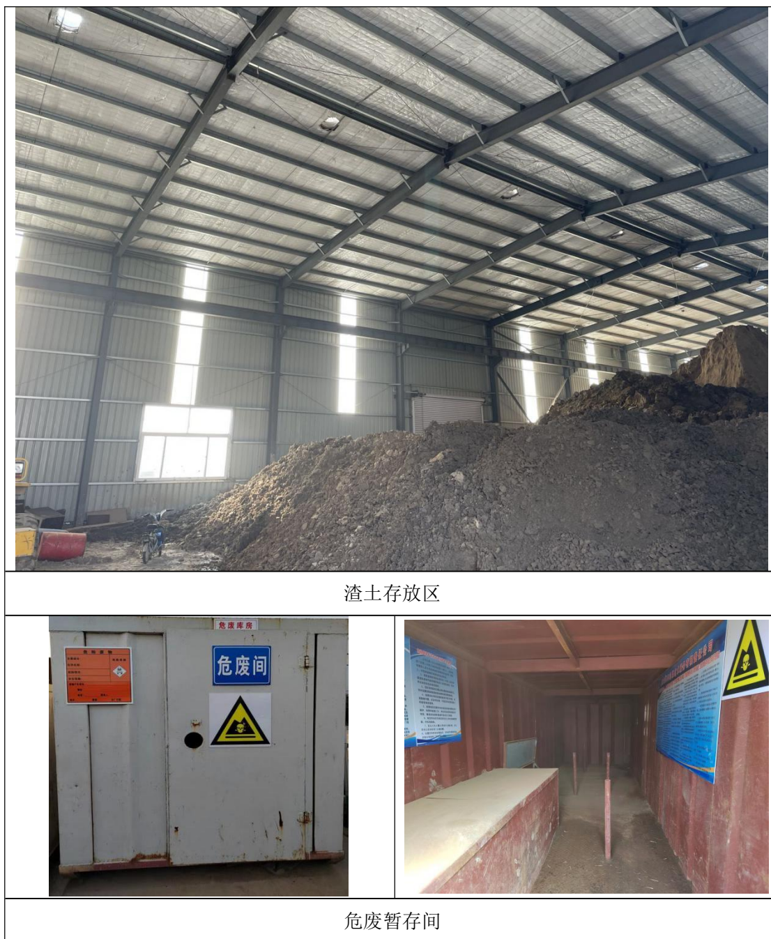
图 4-2 固废暂存图片
