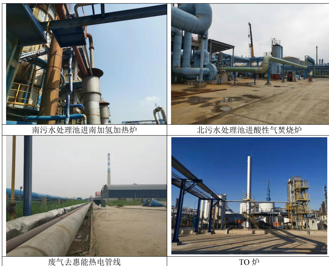
图 3-5 项目建设图片
